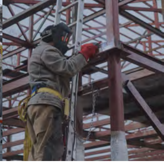
Строительство, монтаж металлоконструкции
